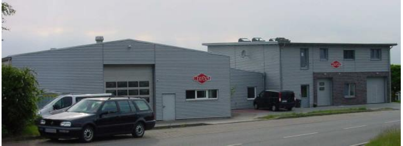
Bild 2: Das Firmengebäude der Herbst Maschinenfabrik GmbH in Buxtehude bei Hamburg
